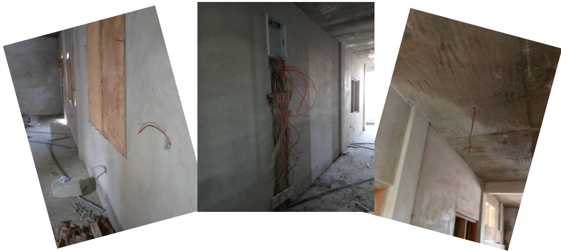
Die Elektrik im Schulbau ist in Arbeit!
